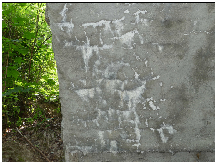
Foto č. 1- Konstrukce K 01 – z podhledu vlevo – výluhy pojiva (foto 2019)
