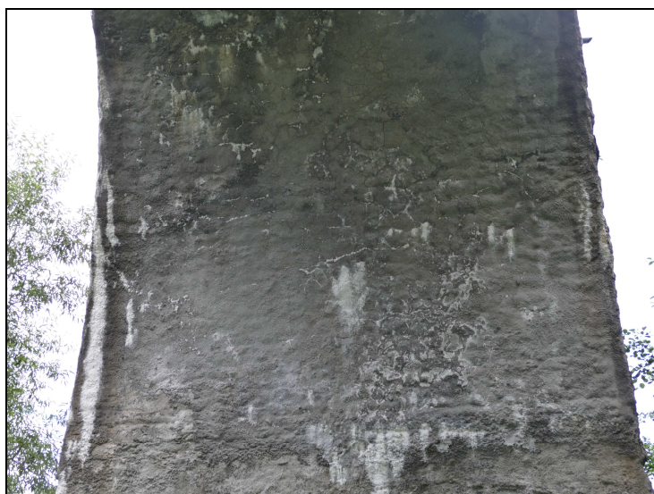
Foto č. 2 - Konstrukce K 03 – z podhledu vlevo – výluhy pojiva (foto 2019)
