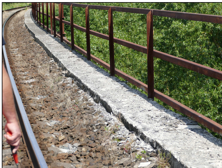
Foto č. 6 – římsa vpravo – degradace horní plochy (foto 2019)
