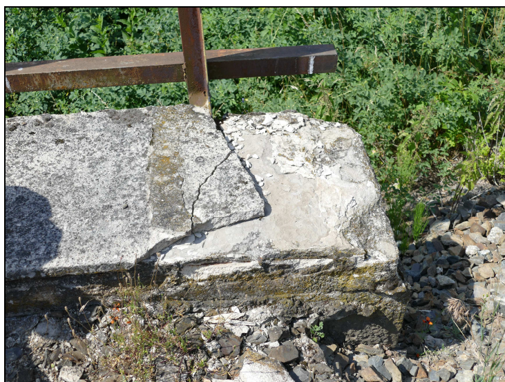
Foto č. 5 - Opěra O 02 – křídlo římsa vlevo – odpadlý povrch (foto 2019)
