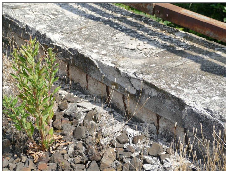
Foto č. 4- Na konci – římsa vpravo – degradace, obnažení výztuže
